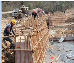
景墙模板安装
