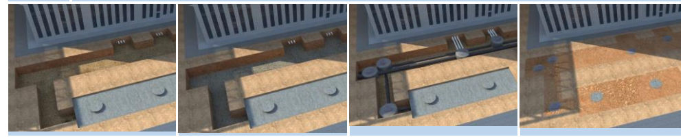
沟槽开挖 垫层施工 管道安装 管道回填
