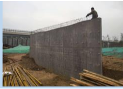
景墙浇筑成型
