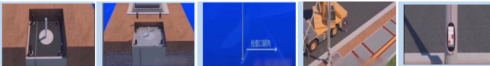
安装预埋件 预埋件锚固 检查灯杆口 吊装灯杆 检查灯杆线盒
