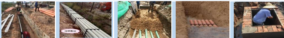
沟槽开挖 管道敷设 沙回填 管道砼包封 手孔井砌筑
