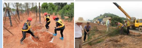
树穴开挖 种植前平衡修剪
