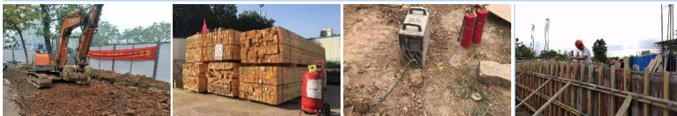
土方逐层开挖 木料堆放防火 电焊机接地 景墙浇筑防止变形
