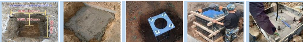
路灯基础开挖 基础垫层 安装预埋件 基础支模 浇筑砼
